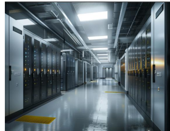
データセンター
