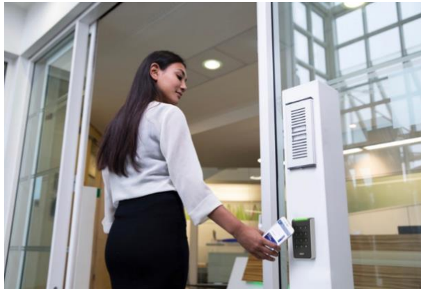
入退室管理システム
